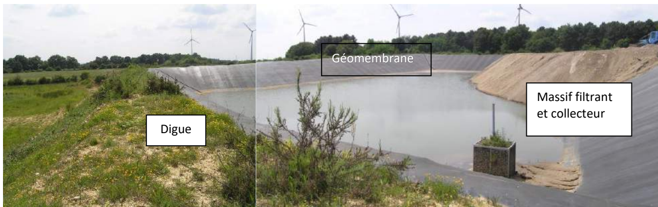
▼ : Vue sur l'alvéole 2A en cours d'exploitation.
